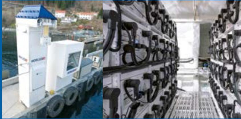
An den Ladestationen in Lavik und Oppedal wird die „Ampere“ aufgeladen (links). In ihrem Inneren befindet sich ein beeindruckendes Batteriepaket (rechts). Dieses hat die Kapazität von 1.600 Standard-Autobatterien.
